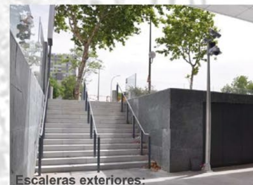
Escaleras exteriores: • Barandillas en distancia <4m • Prolongación pasamanos en desembarco escaleras
