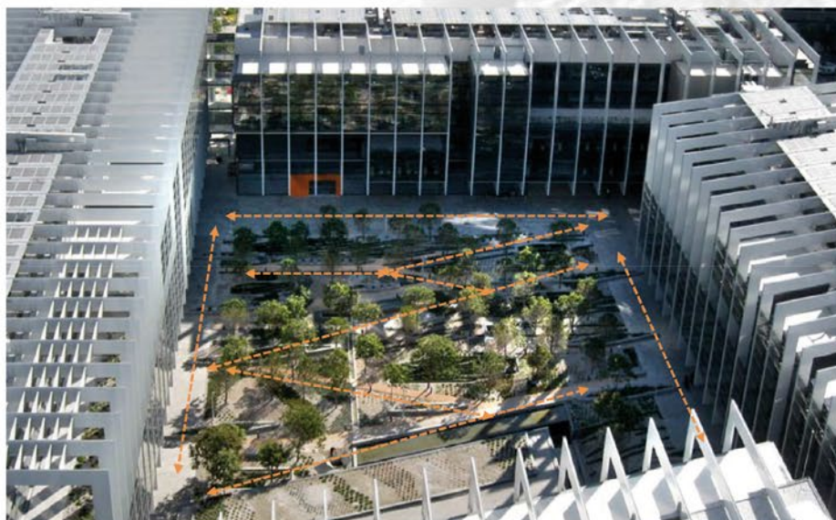
Vista aérea paisajismo y comunicación horizontal, multitud de caminos accesibles
