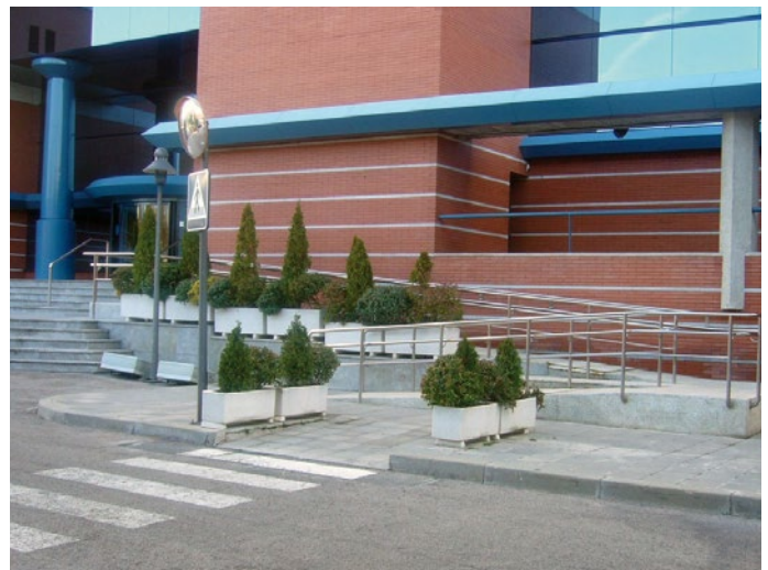
En el itinerario accesible se visualiza el paso de peatones, que conduce al vado peatonal de un único plano, y la rampa exterior con pasamanos a dos alturas. (Fotografía cedida por Acciona)
